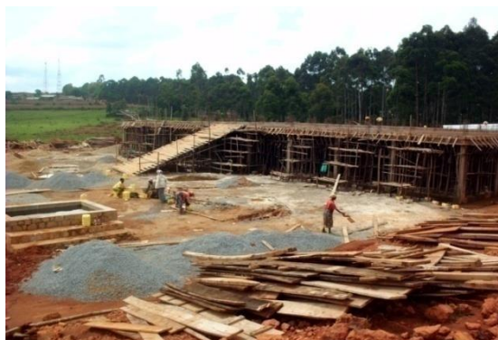
Immeuble en construction à Gitega
